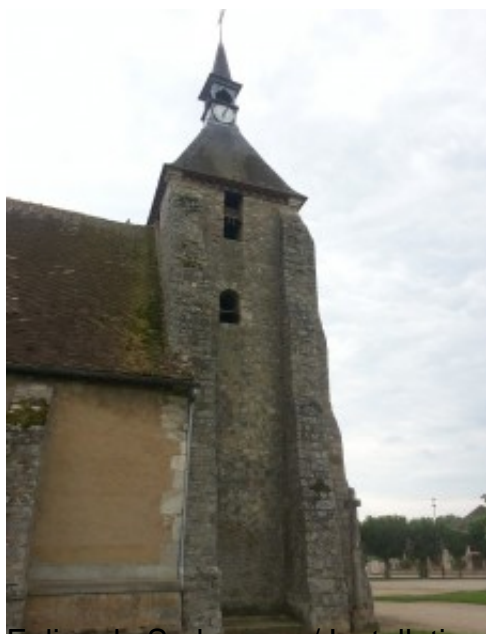
Eglise de Serbonnes / Installation hertzienne
